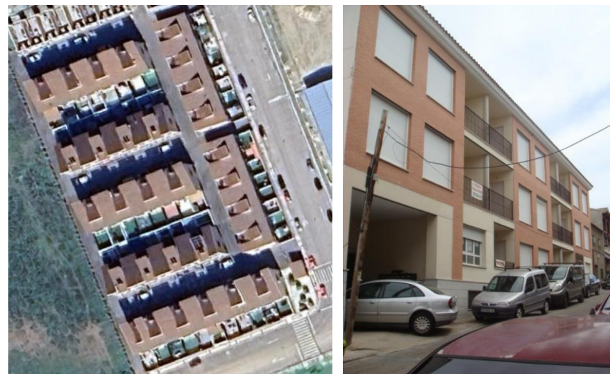
fig 49. Izquierda: conjunto de 83 viviendas unifamiliares construidas en 2008 en el sector VI de Cazalegas. Derecha: edificio de 23 viviendas construido en 2009 en Cebolla
